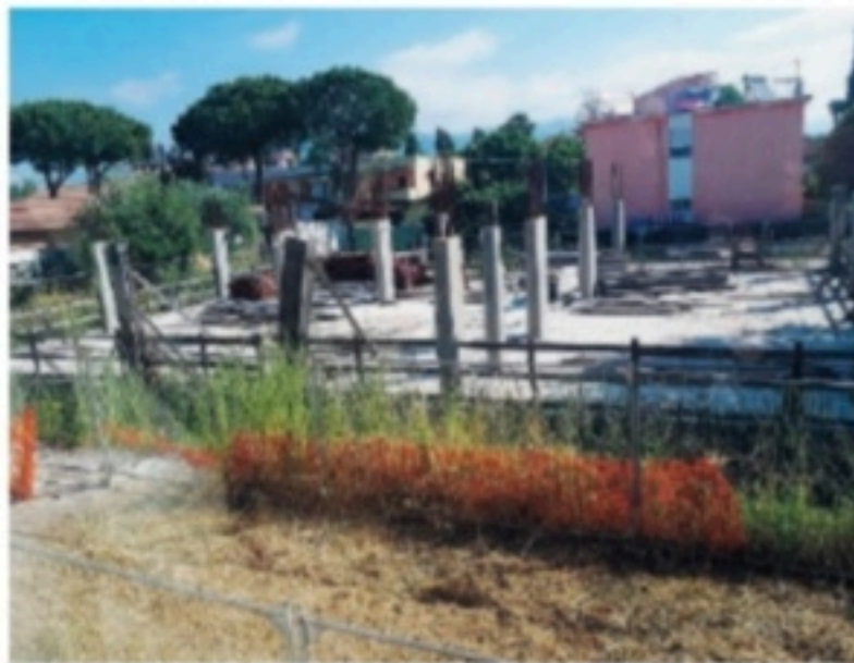
Il cantiere della scuola di Borgo Faiti
